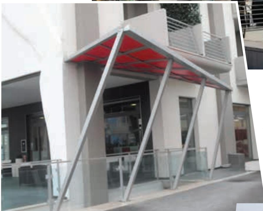
▲ Vela ombreggiante realizzata con tessuto microforato in Pvc, rinforzata perimetralmente e nei punti di ancoraggio. Può essere realizzata di qualsiasi forma e misura.
